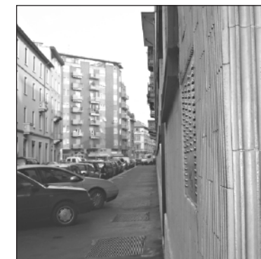
VISIONE DALLA BANDIERA (LATO SINISTRO)
